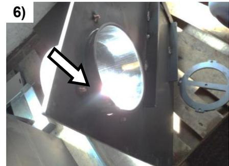
6) Sada možete postaviti produžetak izvoda dimnjaka u rupu
